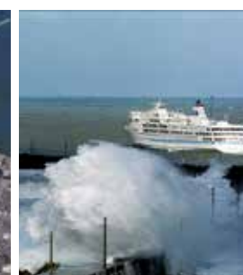
新潟西港の荒波 (国土交通省北陸地方整備局新潟港湾・空港整備事務所提供)
