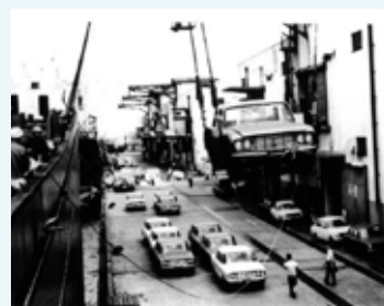
自動車の船積状況
